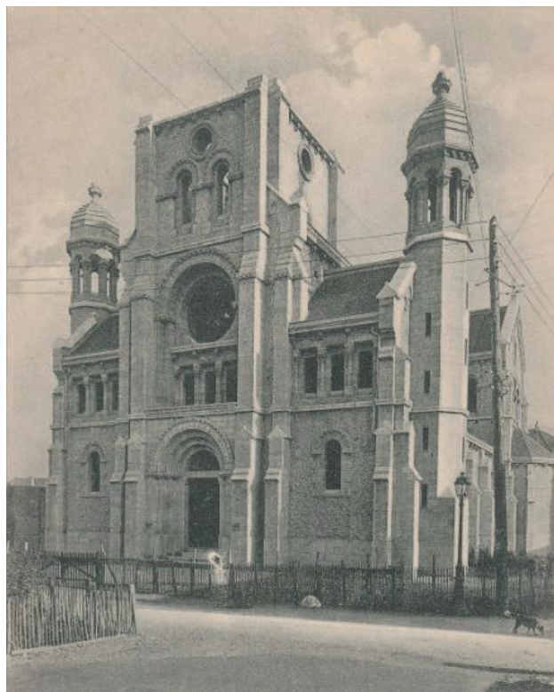
Nouvelle église Saint-Pierre Saint-Paul
